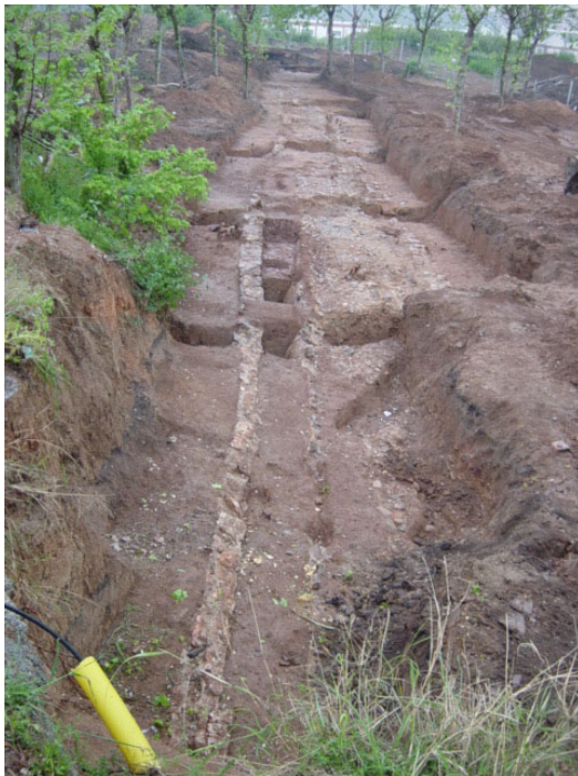
Vista general de les restes des del sud-oest, amb la canalització romana, el camí empedrat i el mur que el delimita.
