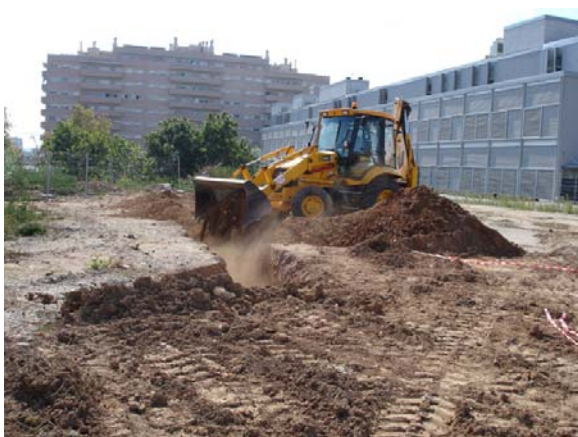
Vista, des del nord, del desenvolupament dels treballs mecànics de reompliment de la rasa.
